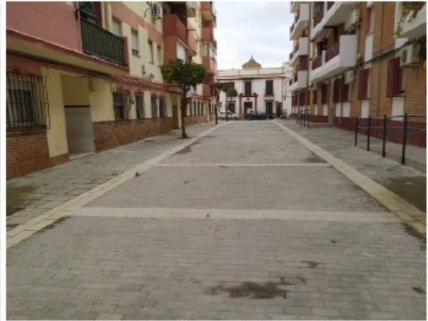
Calle Juan de Robles (peatonalización año 2020)
